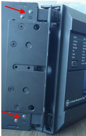
Рисунок 9-18: Відкрутіть монтажний кронштейн з лівої сторони стандартної передньої панелі (зверніть увагу на заклепані петлі з червоними стрілками)
